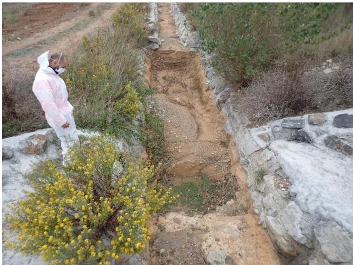
*Illustration 67 : Accumulation de sédiments dans le bassin aval du dégrilleur.*
