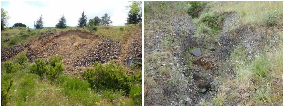
*Illustration 125 : Photographies des figures d'arrachement et ravines sur les banquettes de la verse de Ramèle.*
