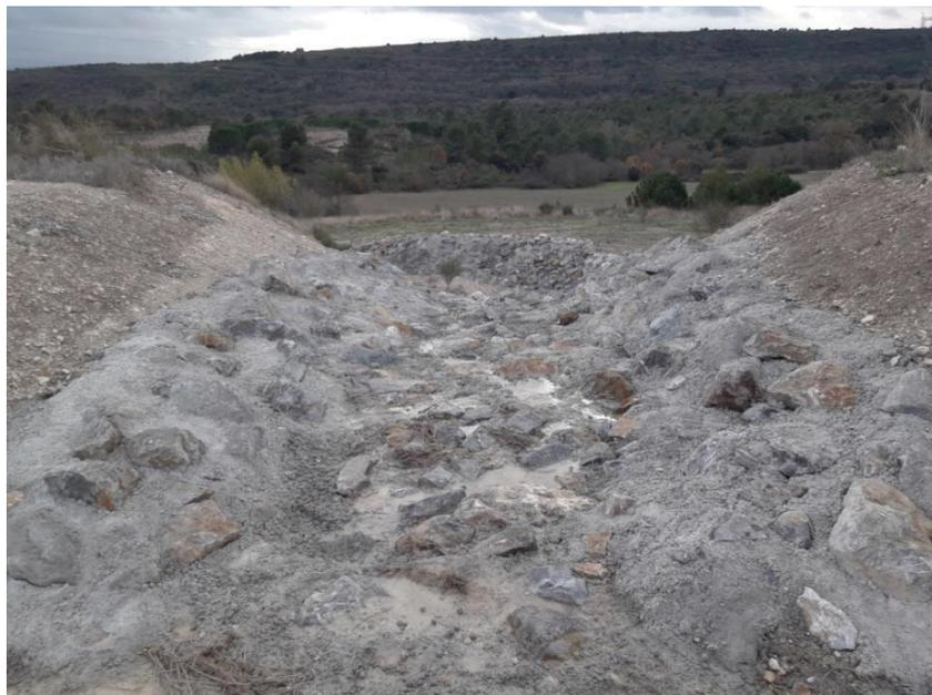
*Illustration 25 : Exutoire avec enrochements bétonnés (milieu plateforme +248).*
